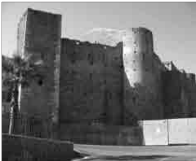
I lavori al castello di Miglionico
